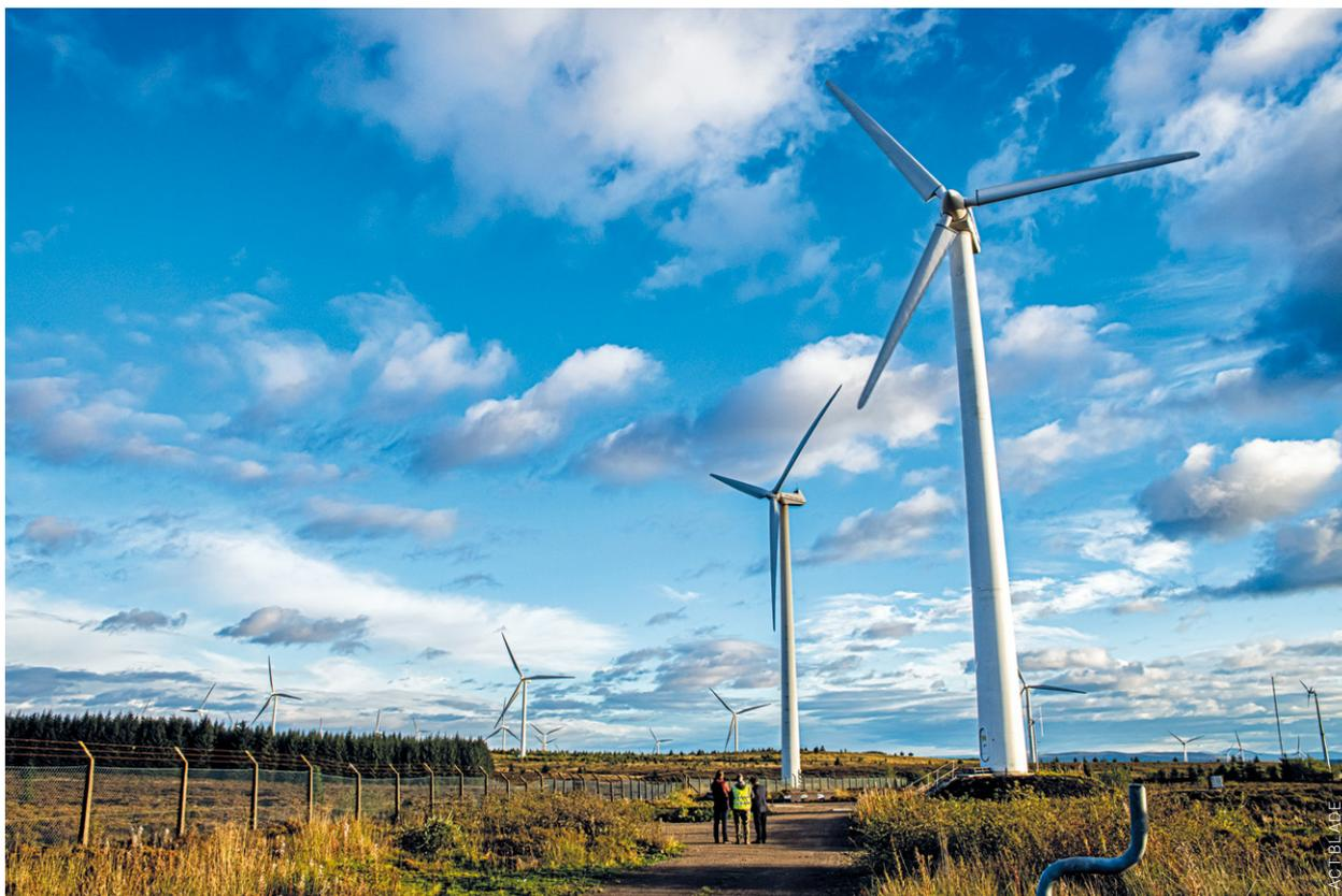
*Trois pales d'ACT Blade de 13 m de long, soit un diamètre de rotor de 27 m, ont été installées et testées pendant six mois sur une éolienne Vestas de 225 kW (au premier plan).*
