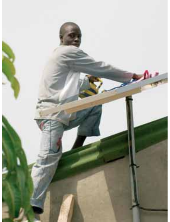
Un technicien du comité de gestion assure la maintenance des systèmes solaires.
