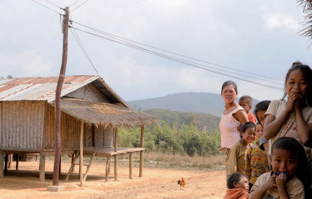
Le réseau de distribution parcourt le village./The local grid covers the entire village.
